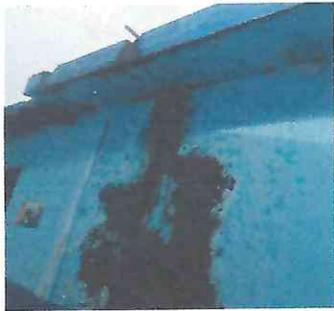
Foto 3: Filtración de terraza por falta de mantenimiento
